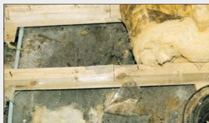
Maakosteus on siirtynyt betonin/rakennusmuovin läpi ja synnyttänyt homekasvustoa.
